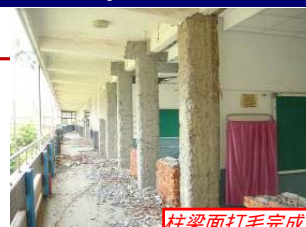
柱梁面打毛完成
