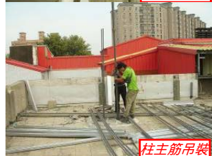
柱植筋鑽孔
