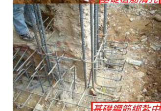
基礎鋼筋綁紮中
