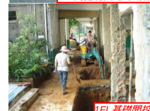
1FL基礎開挖
