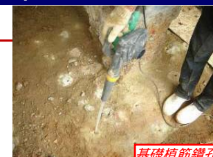
基礎植筋鑽孔
