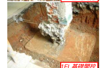
1FL基礎開挖
