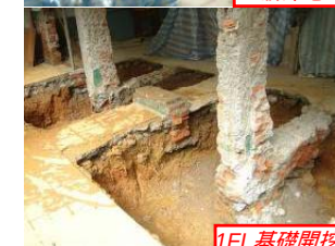
1FL基礎開挖
