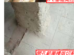
開孔範圍樓版切割
