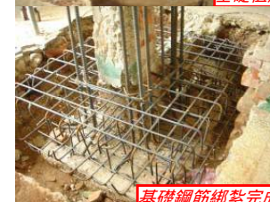
基礎鋼筋綁紮完成
