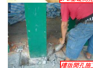
樓版開孔施工
