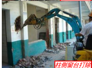
柱側窗台打除
