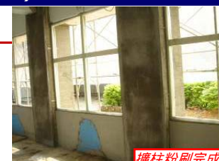
擴柱粉刷完成
