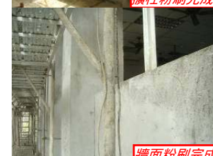
牆面粉刷完成
