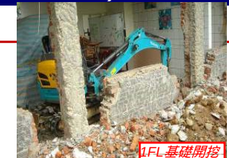
1FL基礎開挖
