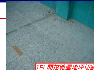
1FL開挖範圍地坪切割
