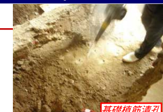
基礎植筋清孔
