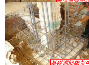
基礎鋼筋綁紮中
