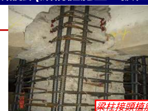
梁柱接頭植筋鑽孔
