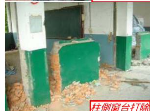
柱側窗台打除
