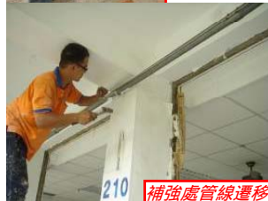
補強處管線遷移
