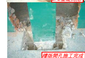
樓版開孔施工完成
