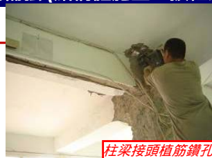
柱植筋鑽孔
